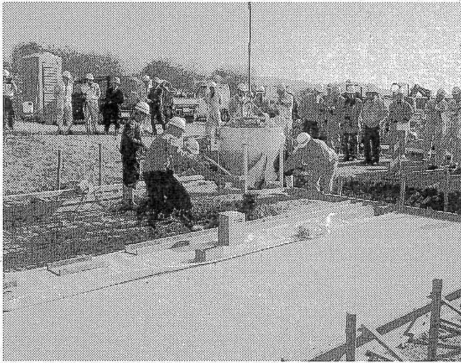
2日間で36㎡を施工。手前は前回の施工箇所
